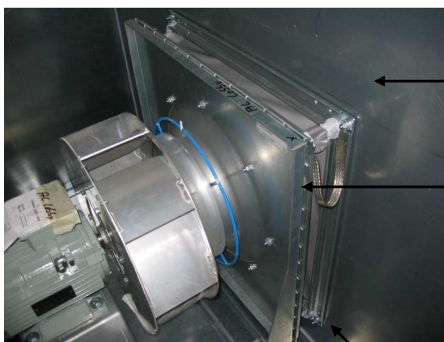
Bild 5.2: Ventilatorabströmseite in der Ventilatorkammer
