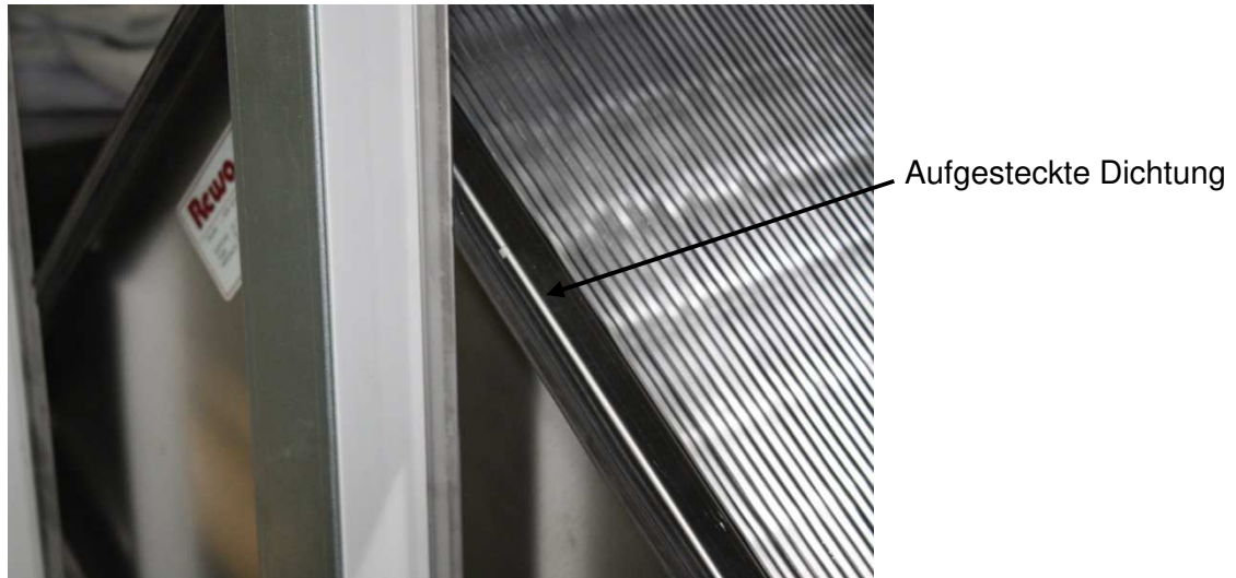
Bild 5.2: Dichtung am Platten-Wärmeübertrager
