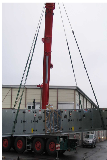
Bild 2.1: Hilfszeuge zum Transport des Klimazentralgerätes durch einen Kran
