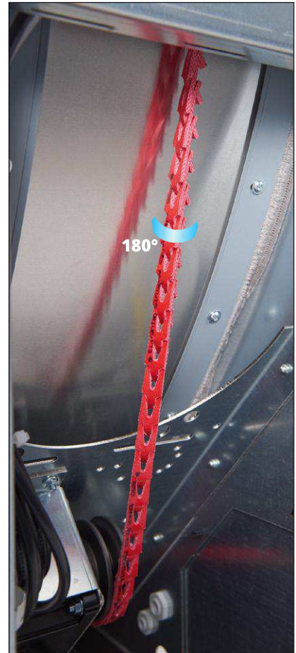
Nach ein paar Umdrehungen der Speichermasse verdreht sich der Antriebsriemen einmalig so, dass die Verschleißzapfen sich nach aussen drehen
