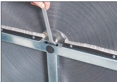
(7) Lösen Sie die Sechskantschraube
