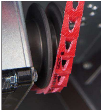
Bei der Montage des Antriebsriemens ist auf die Drehrichtung der Speichermasse zu achten. Die Laufrichtung ist auf den Riementelementen durch ein Pfeil gekennzeichnet
