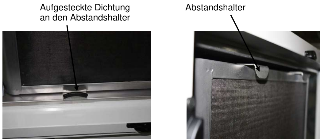
Bild 5.3: Darstellung der aufgesteckten Dichtung an den ROX-Kulissen
