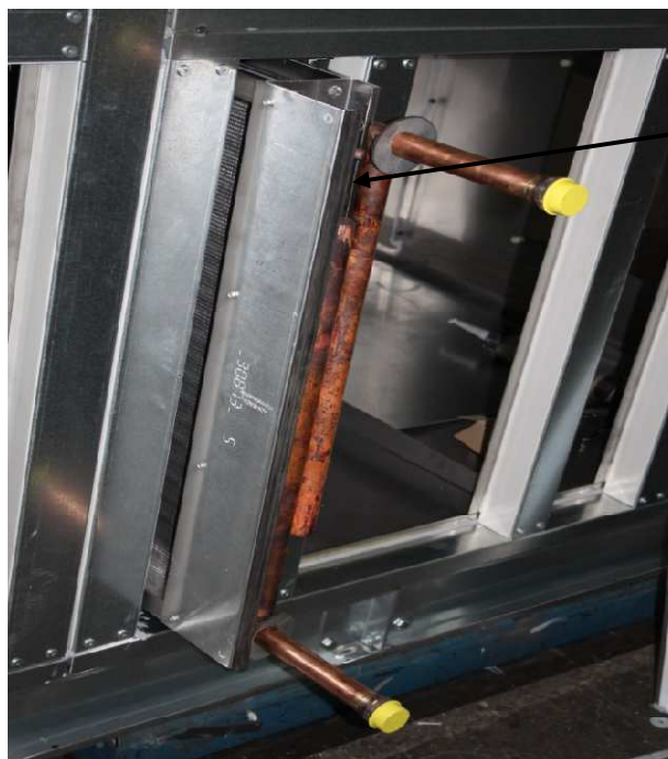
Bild 5.1: Dichtung am Lamellen-Wärmeübertrager
