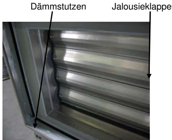
Bild 4.4: Darstellung des Dämmstutzens und der Jalousieklappe
