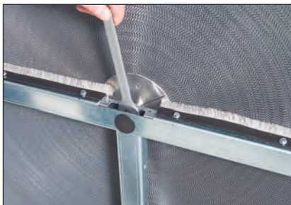
(7) Lösen Sie die Sechskantschraube
