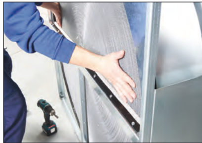
(8) Neigen Sie das Wärmerad vorsichtig. Beachten Sie dabei, dass die empfindliche Speichermasse nicht beschädigt wird.
