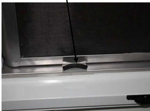
Bild 5.3: Darstellung der aufgesteckten Dichtung an den ROX-Kulissen
