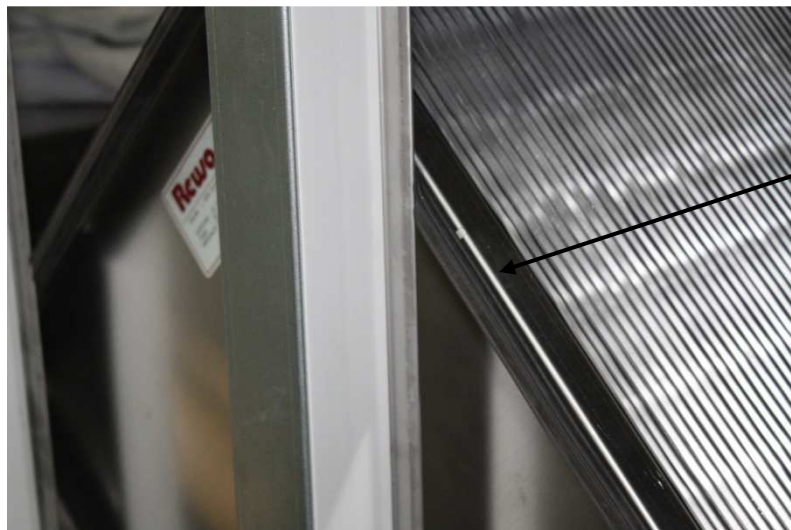
Bild 5.2: Dichtung am Platten-Wärmeübertrager
