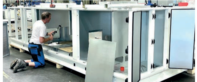
Perfekt gefertigte Komponenten ermöglichen eine passgenaue und einfache Montage der teilweise sehr komplexen Klimaanlagen.
