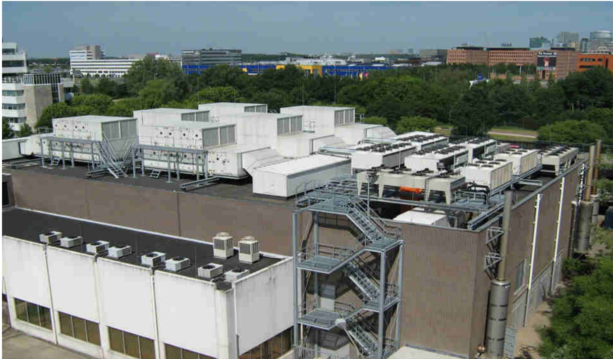
Bild 1.1: ROX-Dachzentralen zur Klimatisierung von Nichtwohngebäuden
