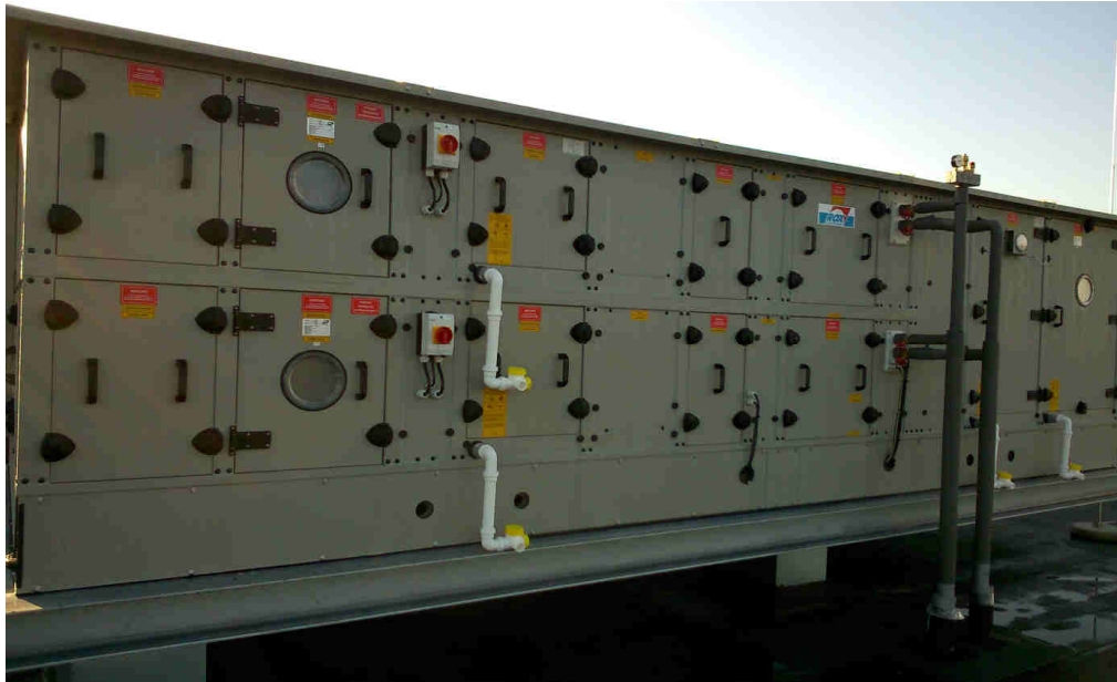
Bild 1.2: ROX-Dachzentralen in feuerverzinkter und lackierter Ausführung
