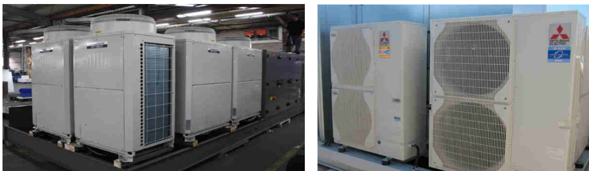
Bild 2.3: Darstellung der bei ROX eingesetzten integrierten Fremdwärmepumpensysteme
