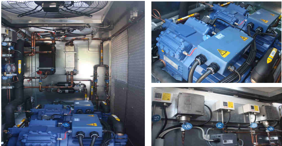
Bild 2.4: Darstellung der Kältekammer der ROX-Kälteanlage R290
