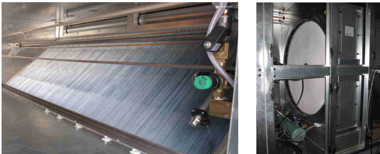
Bild 2.1: Integrierte regenerative und rekuperative ROX-WRG-Systeme
